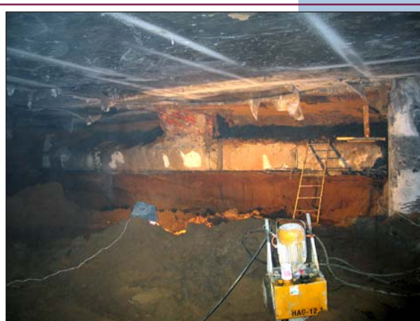
Рис. 18. Очередной сюрприз – во время экскавации грунта под защитой перекрытия над третьим подземным этажом обнаружена старая монолитная железобетонная плита.
