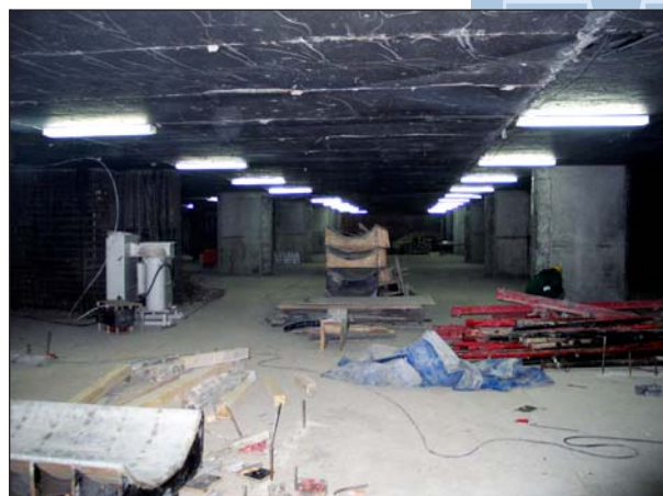
Рис. 11. Завершение возведения монолитных железобетонных обойм усиления буровых колонн на третьем подземном этаже.
