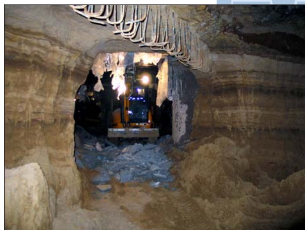
Рис. 6. Есть сбойка эскавации грунта под защитой перекрытия над третьим подземным этажом.
