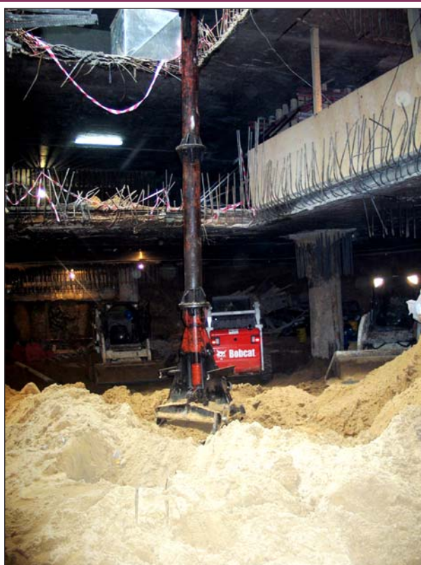
Рис. 13. Выдача грунта грейферным экскаватором «Atlas 1074» через технологический проем под погрузку в автосамосвал во время экскавации под защитой перекрытия над четвертым подземным этажом.
