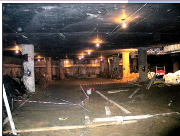
Рис. 12. Экскавация грунта под защитой перекрытия над четвертым подземным этажом. Подготовка грунтового основания к бетонированию захватки перекрытия над пятым подземным этажом.
