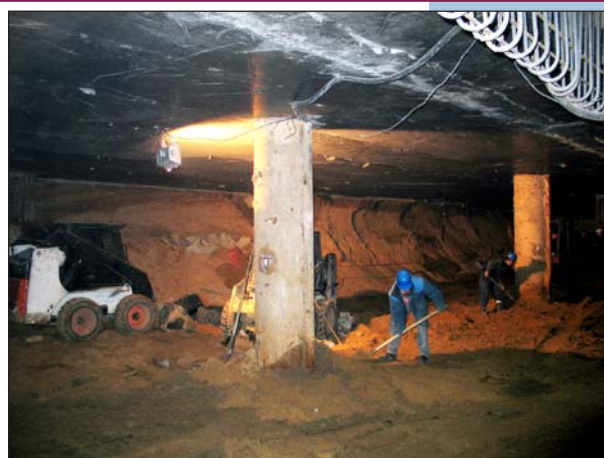
Рис. 14. Экскавация грунта под защитой перекрытия над четвертым подземным этажом вблизи рампы.
