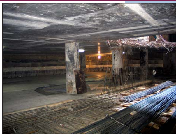
Рис. 9. Возведение монолитного железобетонного перекрытия над четвертым подземным этажом безопалубочным способом на подготовленном грунтовом основании.
