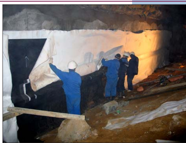
Рис. 19. Гидроизоляция опорной штрабы в стене из буросекущихся свай на третьем подземном этаже.
