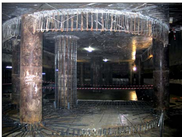
Рис. 10. Возведение монолитного железобетонного перекрытия над четвертым подземным этажом в зоне вывешенной на буровых колоннах рампы.
