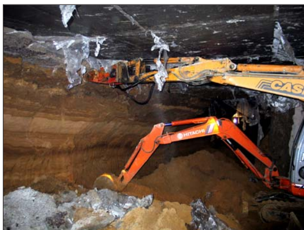
Рис. 5. Эскавация грунта под защитой перекрытия над третьим подземным этажом.
