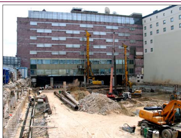
Рис. 1. Завершение возведения стен ограждения котлована из буросекущихся свай. Возведение буровых колонн.
