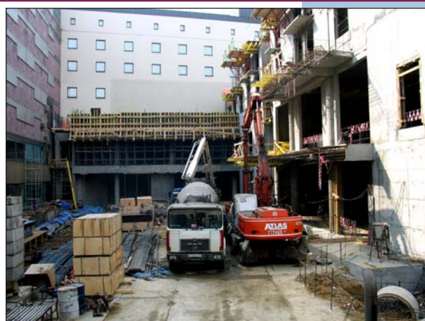
Рис. 8. Завершение возведения четвертого надземного этажа со стороны двора.
