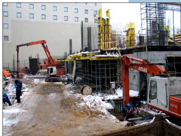
Рис. 3. Временная строительная площадка на перекрытии. Начало экскавации грунта под защитой перекрытий.
