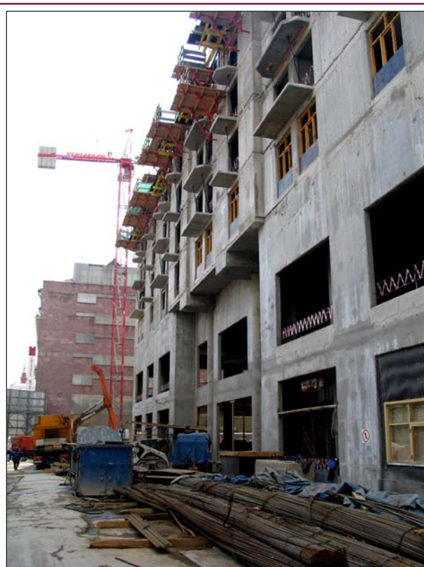
Рис. 15. Возведение конструкций шестого и седьмого надземных этажей.
