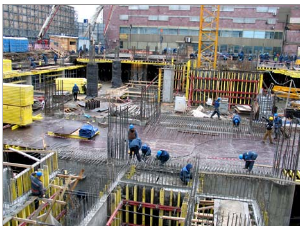
Рис. 2. Возведение конструкций второго и первого подземных этажей в открытом котловане.
