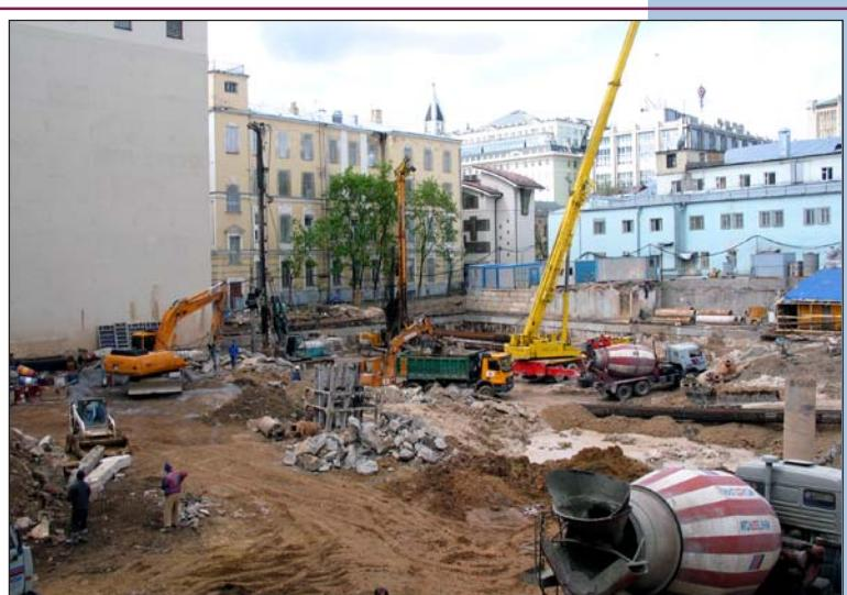
**Рис. 7.** Возведение буровых колонн вдоль стен под защитой ограждения котлована из буросекущихся свай.
