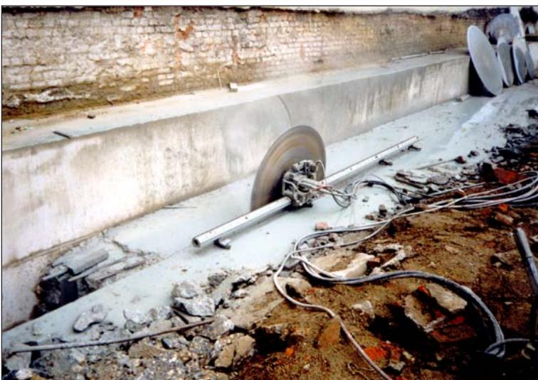
**Рис. 4.** Устройство форшахты и прорези под будущую стену ограждения котлована в старой фундаментной плите, обнаруженной возле гостиницы «Националь».
