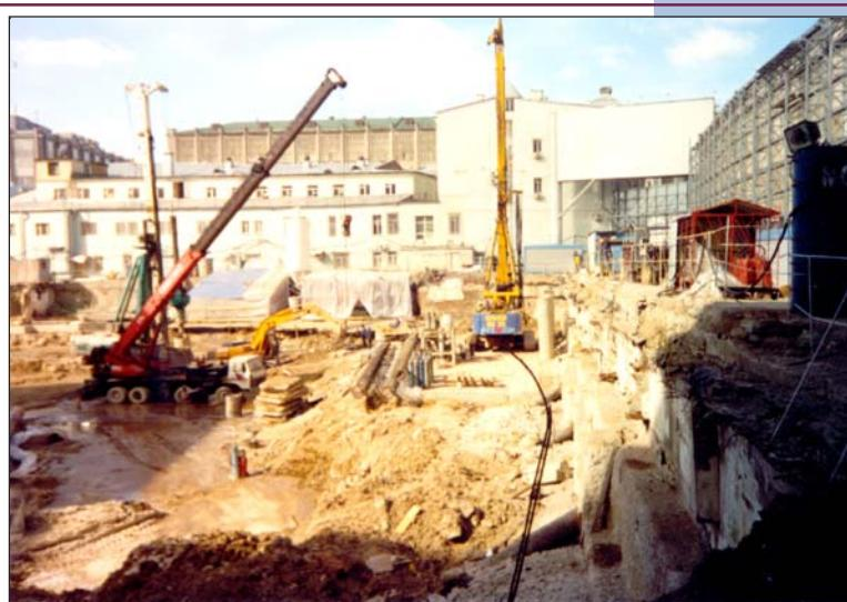
**Рис. 5.** Возвведение стены из буросекущихся свай вдоль коллектора мелкого заложения с гребня пригрузочной бермы. Опережающая разборка старых конструкций и устройство форшахты под защитой временной металлической подкосной крепи.
