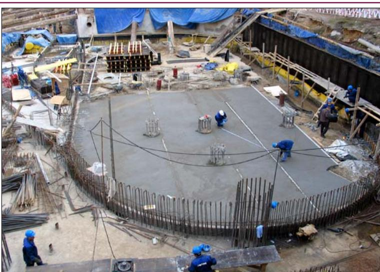
**Рис. 8.** Устройство выравнивающей стяжки из цементно-песчаного раствора на подготовленном грунтовом основании перед возведением захватки перекрытия над 3-м подземным этажом в зоне рампы.
