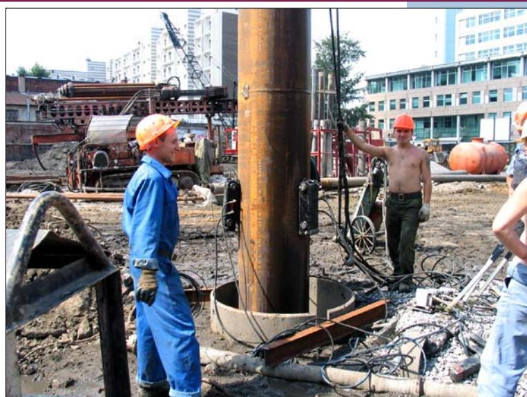
**Рис. 9.** Монтаж извлекаемых гидродомкратов на трубе-опалубке арматурного каркаса буровой колонны увеличенной глубины заложения.
