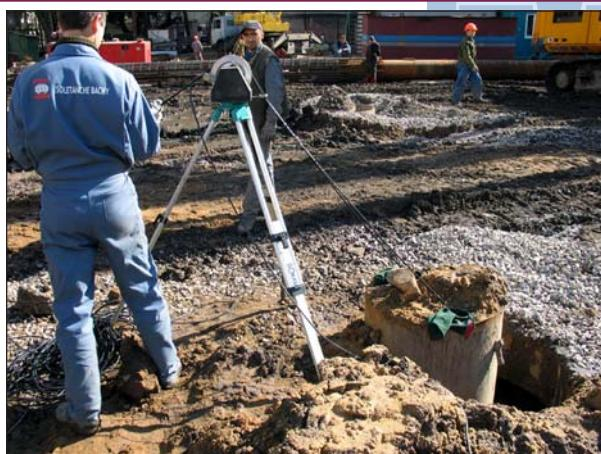
**Рис. 12.** Ультразвуковой контроль качества бетонирования буровой колонны.
