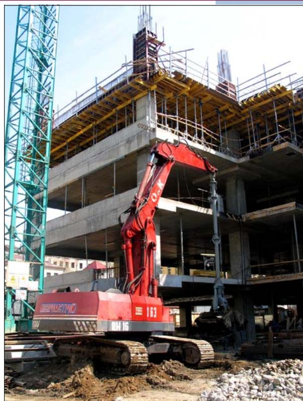
**Рис. 18.** Начало экскавации грунта на уровне B2 под защитой перекрытия на отм. -4,700 м.
