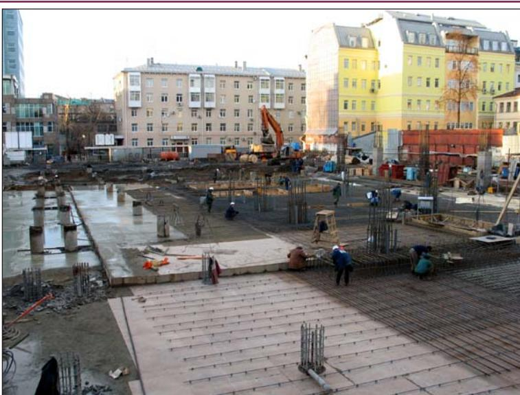
**Рис. 13.** Возвведение перекрытия на отм. 0,000 м безопалубочным способом на подготовленном грунтовом основании.
