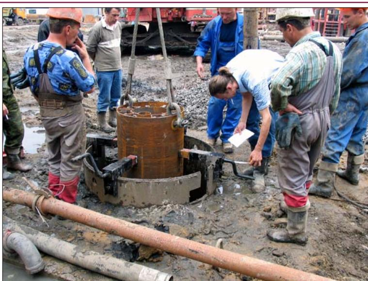
**Рис. 10.** Центрирование арматурного каркаса колонны буровой колонны стандартной длины.
