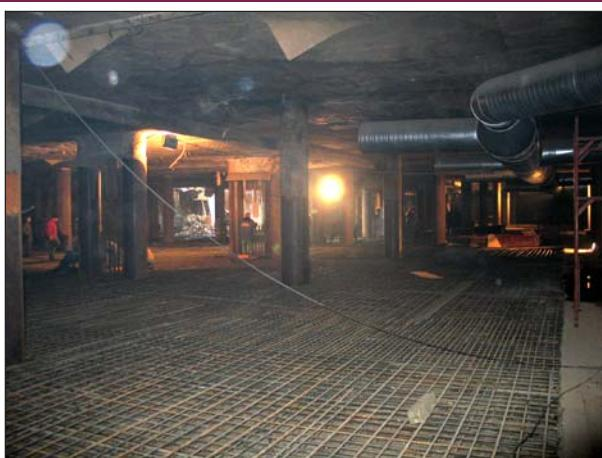
**Рис. 17.** Возведение перекрытия на отм. -4,700 м безopalубочным методом.
