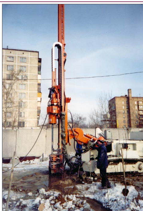
Рис. 7. Выполнение вертикальных свай ограждения котлована.
