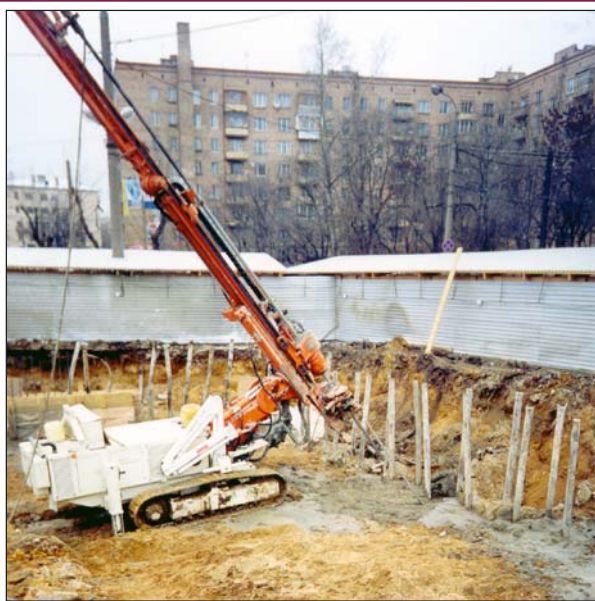
Рис. 8. Выполнение анкерных свай постоянного крепления котлована.
