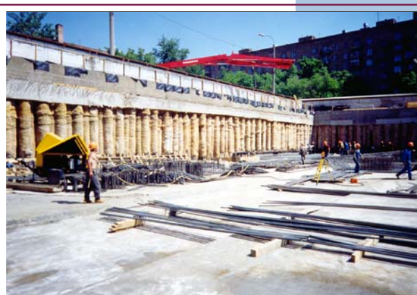
Рис. 9. Отсутствие подкосной крепи упрощает производство СМР в котловане.
